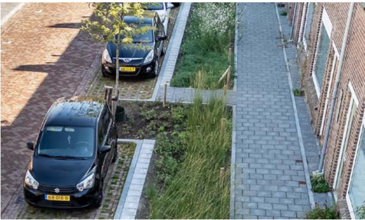
Waterinfiltratie in plant- en parkeervakken
